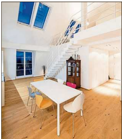
Geländer mit Flacheisenfüllung. Ein lichter Aufgang. FOTOSPITZBART
